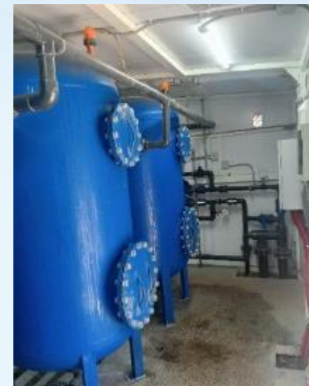
Строительство станции обезжелезивания в ДРОЦ «Пралеска» Жлобинского района
