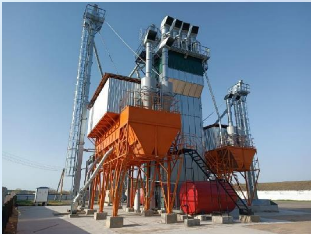
Строительство ЗСК в аг. Залесье Чечерского района
