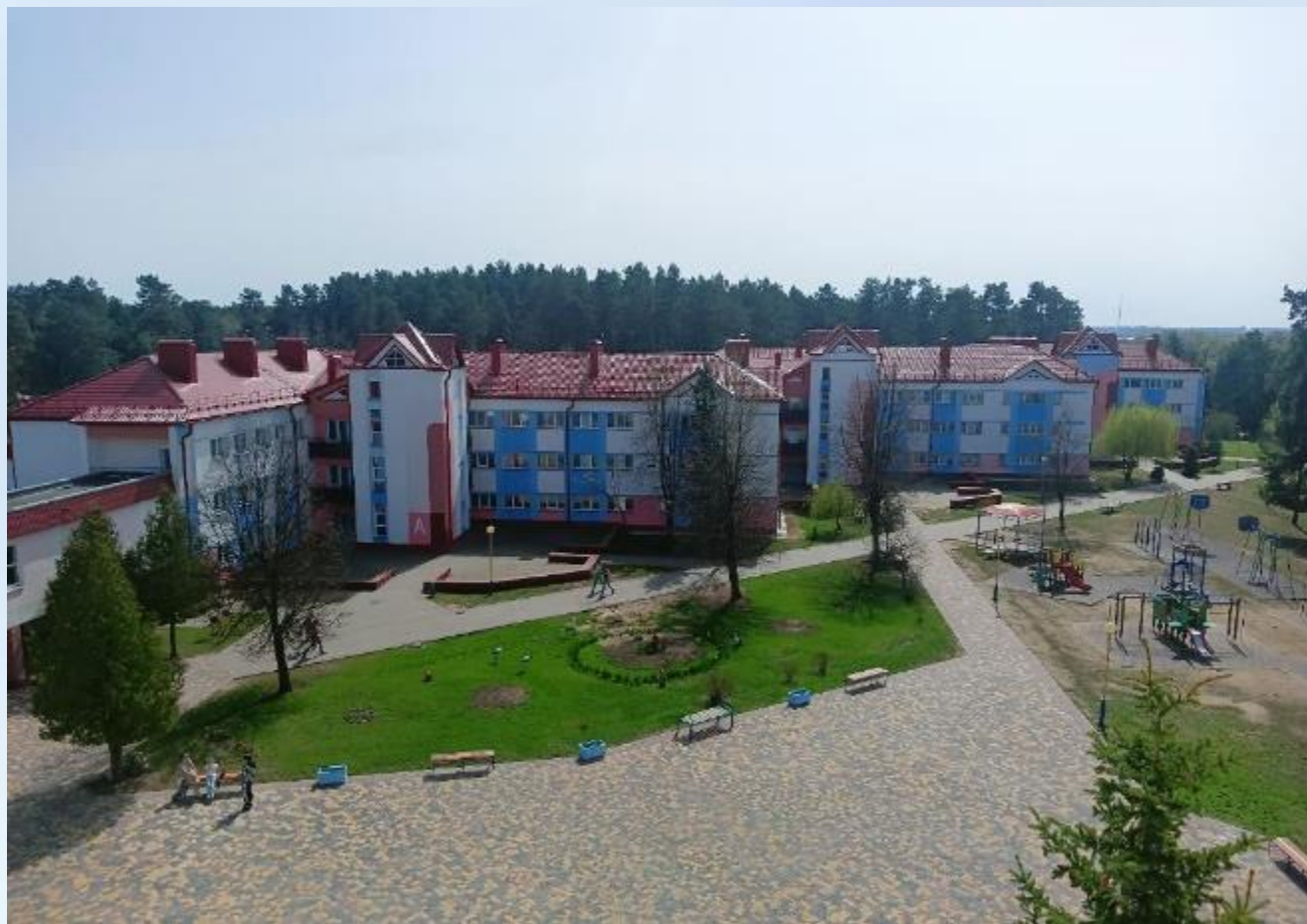
Модернизация кровли спальных корпусов ДРОЦ «Пралеска» Жлобинского района
